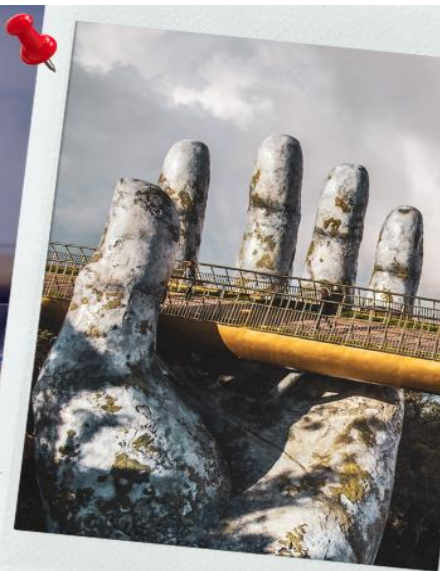
Golden Bridge สะพานบนมือยักษ์
