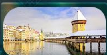
สะพานไมซ์าเปค
