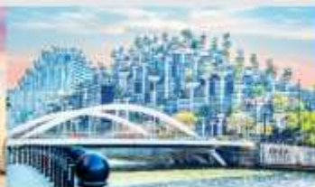
อาคารฟันทันไม
